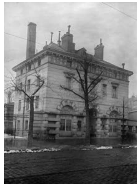
21. Paris. Place Denfert-Rochereau. Ancienne barrière de Nicolas Ledoux, architecte français. © Maurice-Louis Branger / Roger-Viollet
